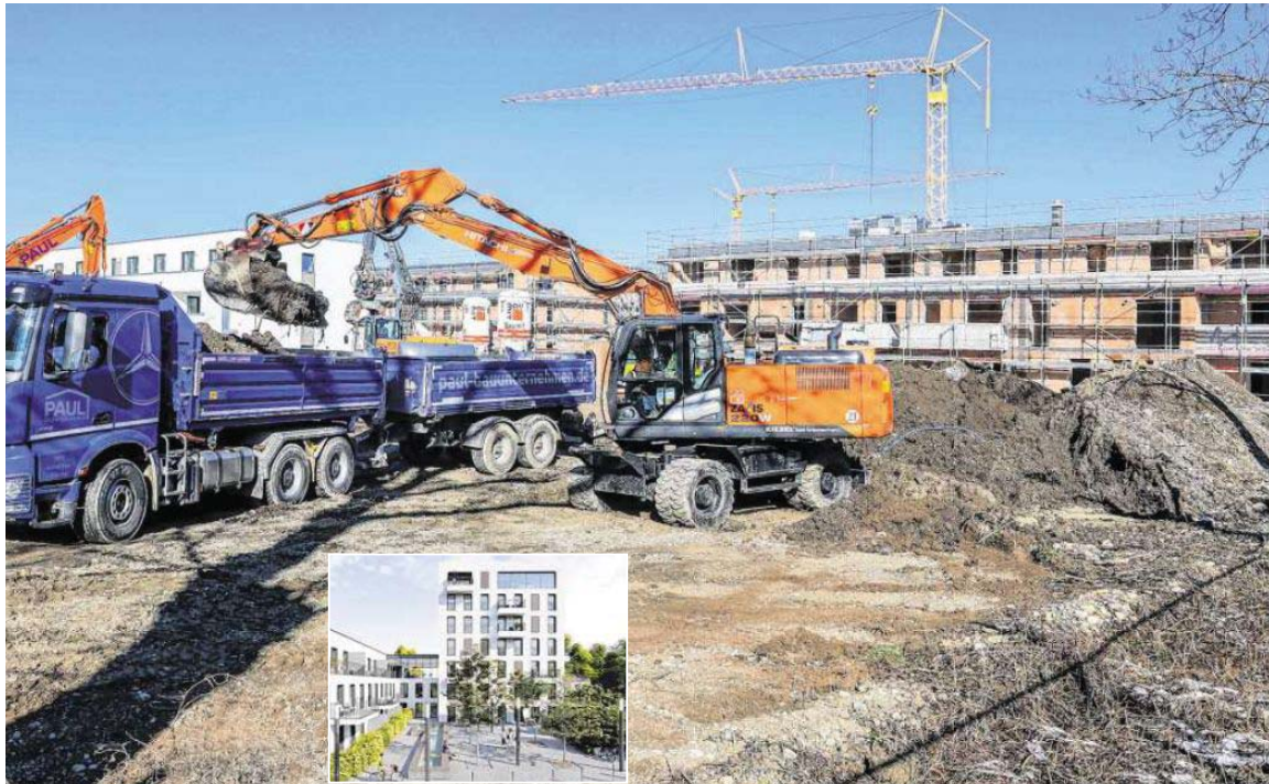
Im neuen Wohnpark Momm-Piazza hat gerade der Bau eines Solitärs begonnen. Das Haus wird knapp 22 Meter hoch (kleines Foto).
