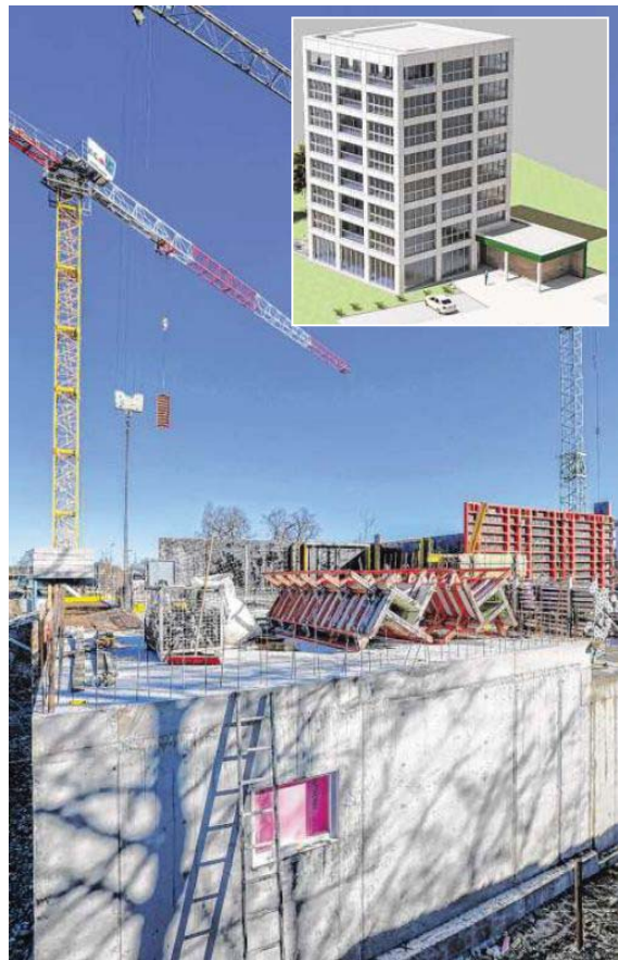
Das Fundament des Bahnhoftowers steht bereits. Geplant ist ein Gebäude mit Büros und Wohnungen (kleines Foto).
