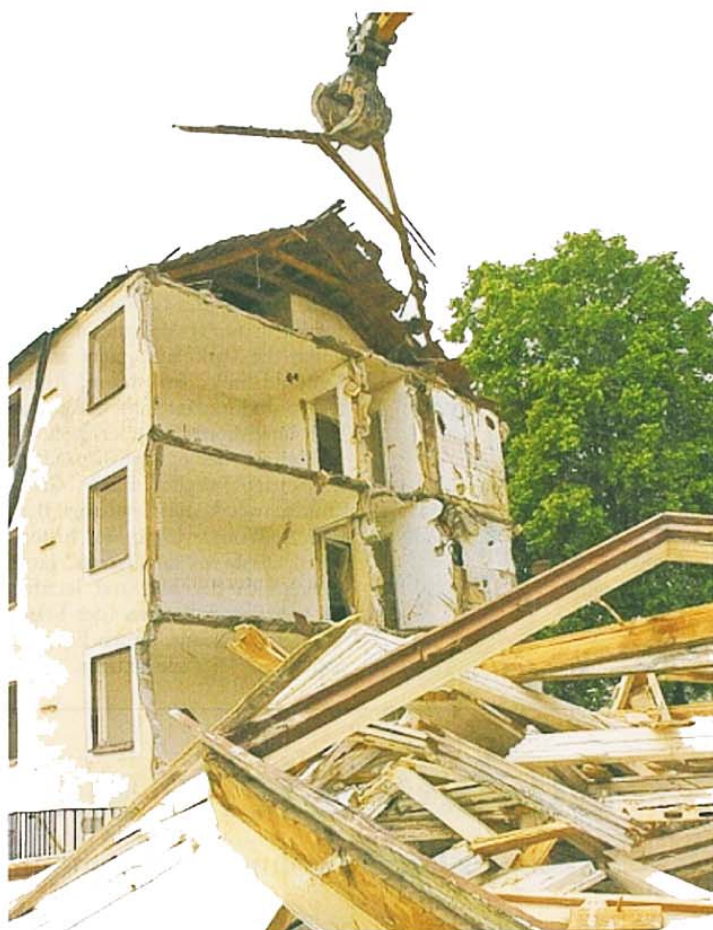
Im Reval-, Narva- und Dorpatweg werden knapp 100 Wohneinheiten abgerissen. Dort entsteht später dieselbe Zahl an neuen Wohnungen. Foto: Waltl-Jensen
