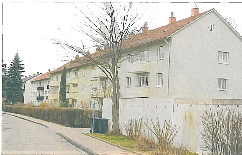
Das Kaufbeurer Unternehmen Immo-Holding hat im vergangenen Jahr 144 Wohneinheiten im Reval-, Dorpat- und Narvaweg von der Bundesrepublik Deutschland erworben. Im südlichen Grundstücksbereich der Siedlung sollen Gebäude durch fünf neue Mehrfamilienhäuser ersetzt werden. Foto: Brigitte Waltl-Jensen
