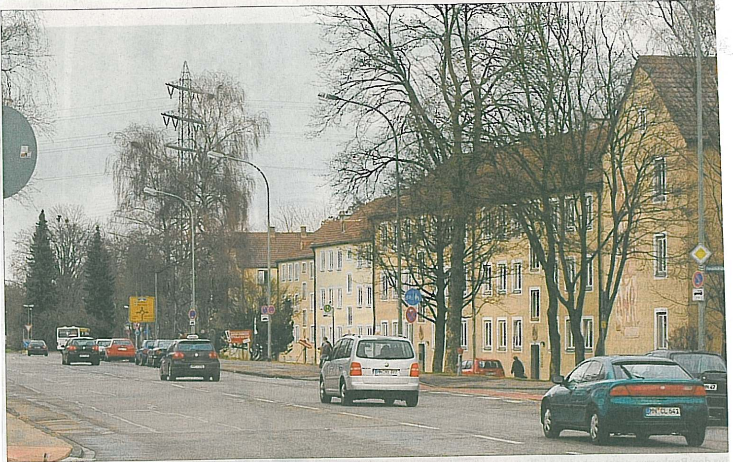
Die Kaufbeurer Unternehmensgruppe Immo Holding modernisiert derzeit Wohnungen in der Münchner Straße. Im rückwärtigen, von der Straße abgewandten Bereich sollen fünf Wohnblöcke abgerissen werden. Hier ist ein neues Wohnbau-Projekt angedacht. Foto: Schulze
